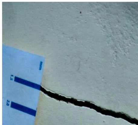
Figura 5 – Rachadura em parede.
