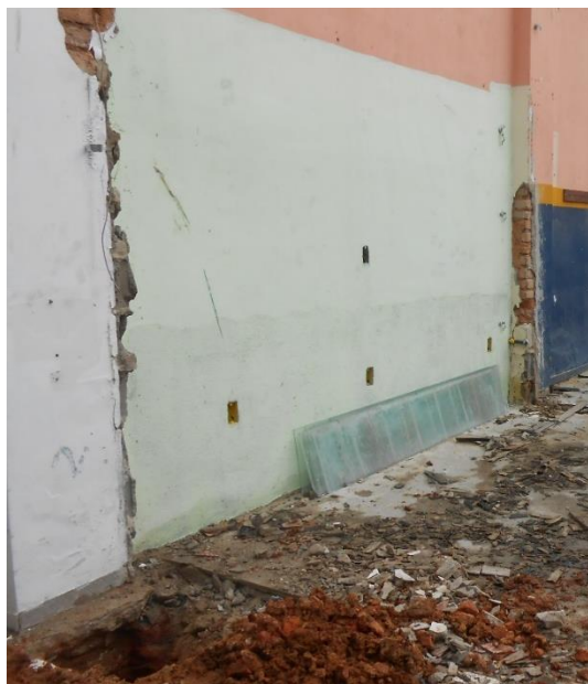
Figura 8 – Abertura dos buracos
