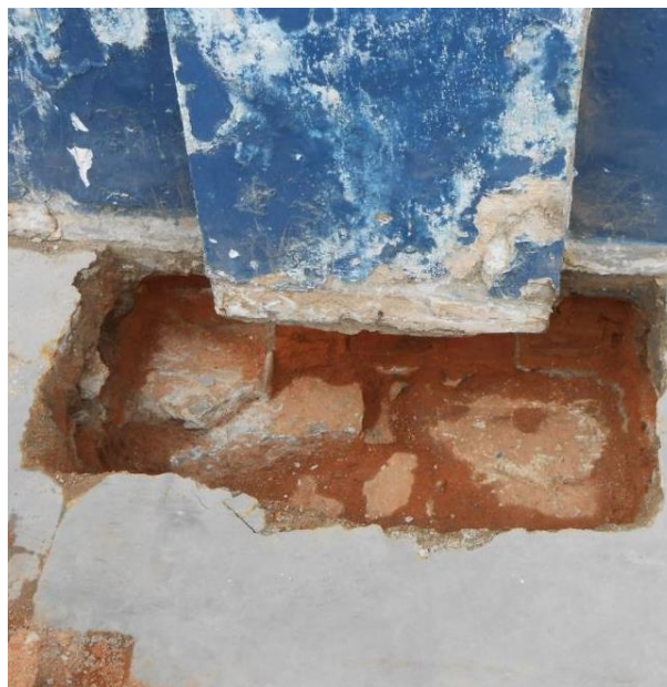
Figura 9 – Identificação do tipo de fundação
