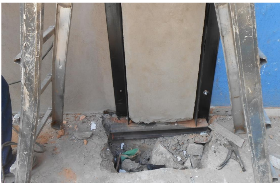
Figura 13 – Reforço de fundação
